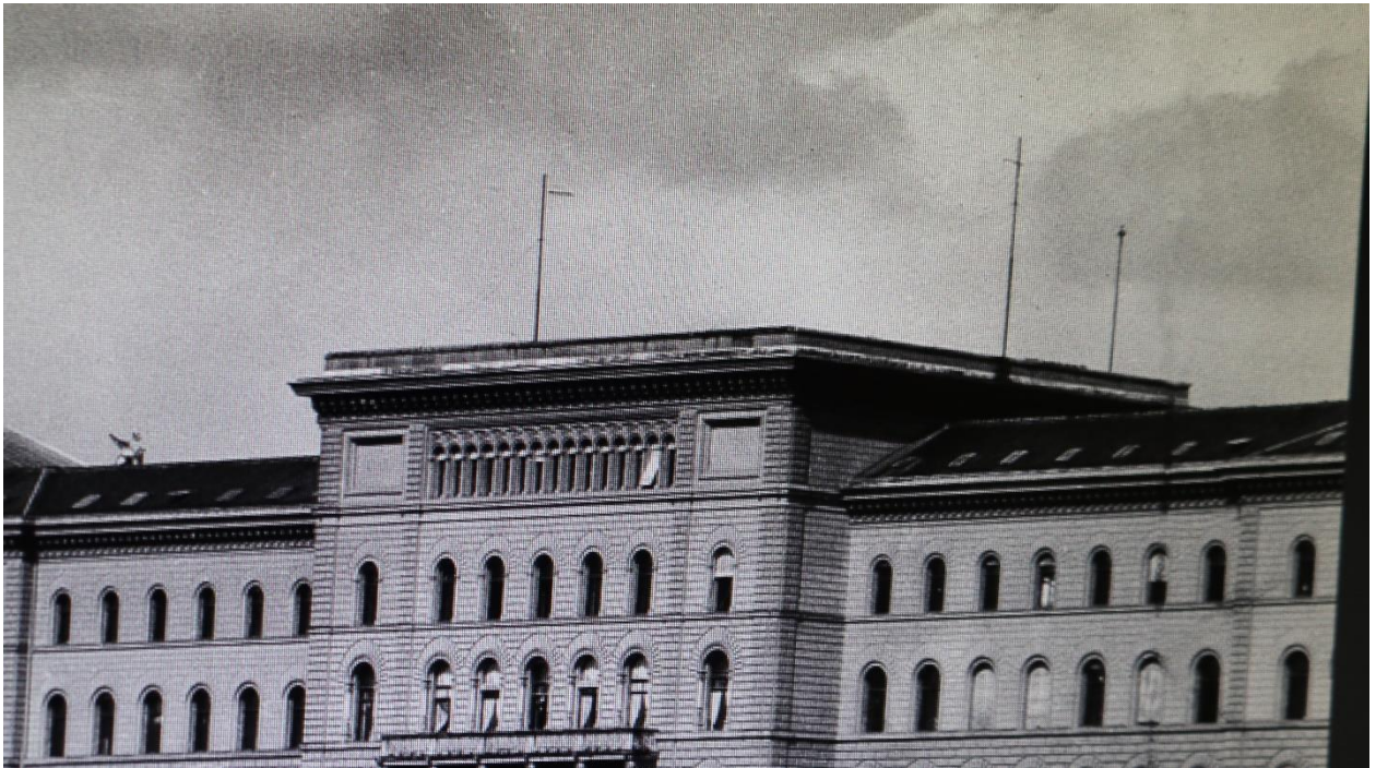
Der Armeenachrichtendienst AND, die Kurzwellenantennen
