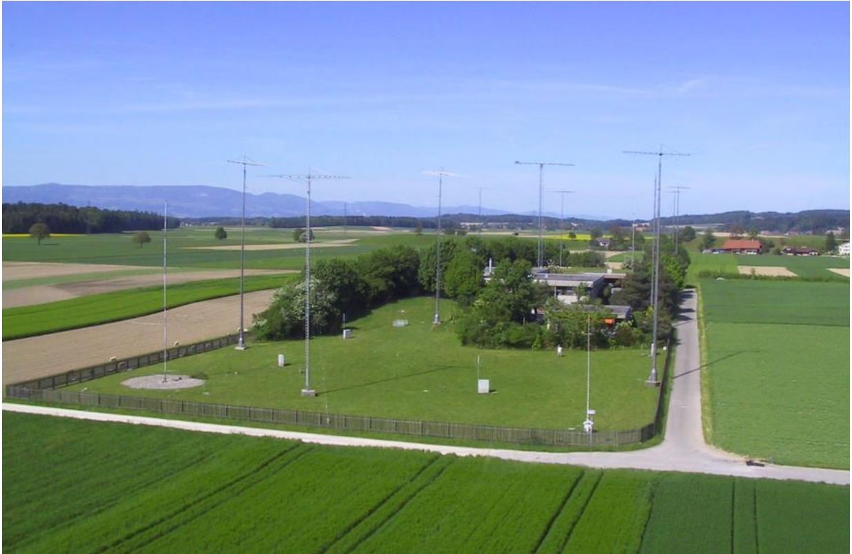
EPD/EDA - die Mittelland: Betriebs- und Empfangsanlage , befand sich in Murain bei Ersigen BE , sie ist eine klassifizierte militärische Anlage.
