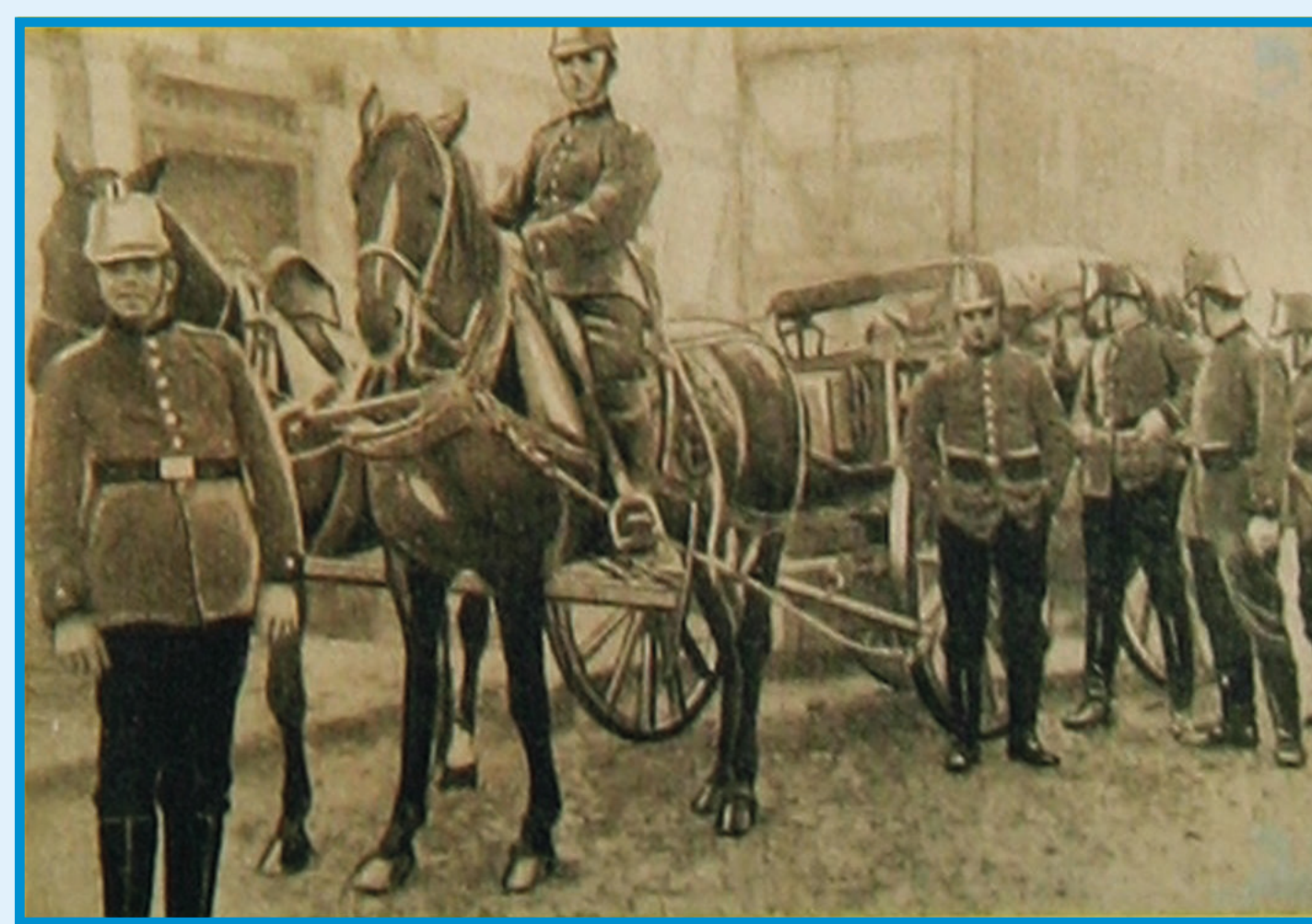
Ein Bautrupp des Telegr.-Batl. Nr. 2 – Marschpause –
