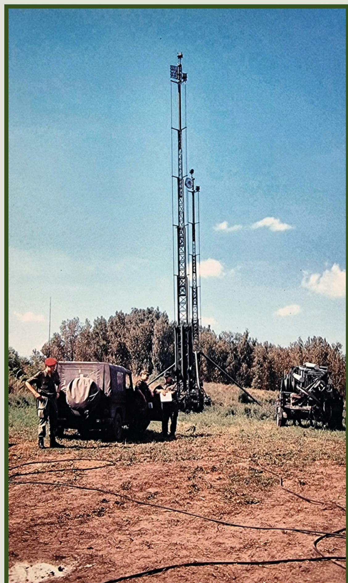
Der aufgebaute Antennenträger für die Richtfunkverbindungen
