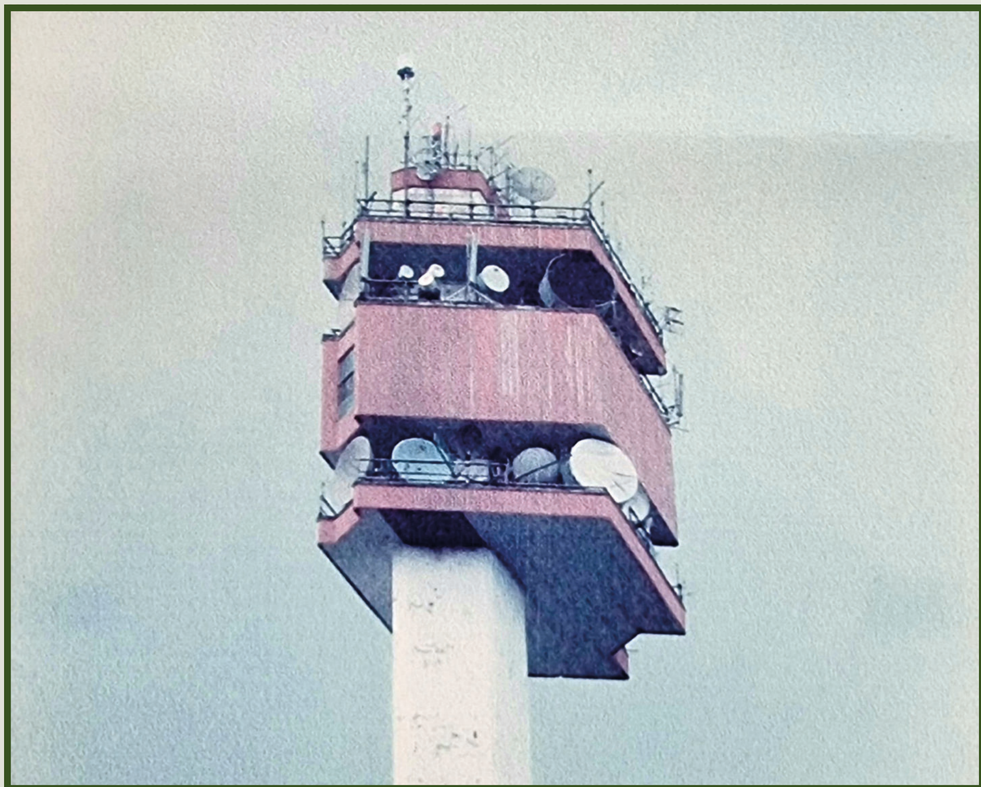
Der von der Fernmeldetruppe beim SFOR-Einsatz genutzte stationäre Fernmeldeturm auf dem Trebjevic in Sarajevo
