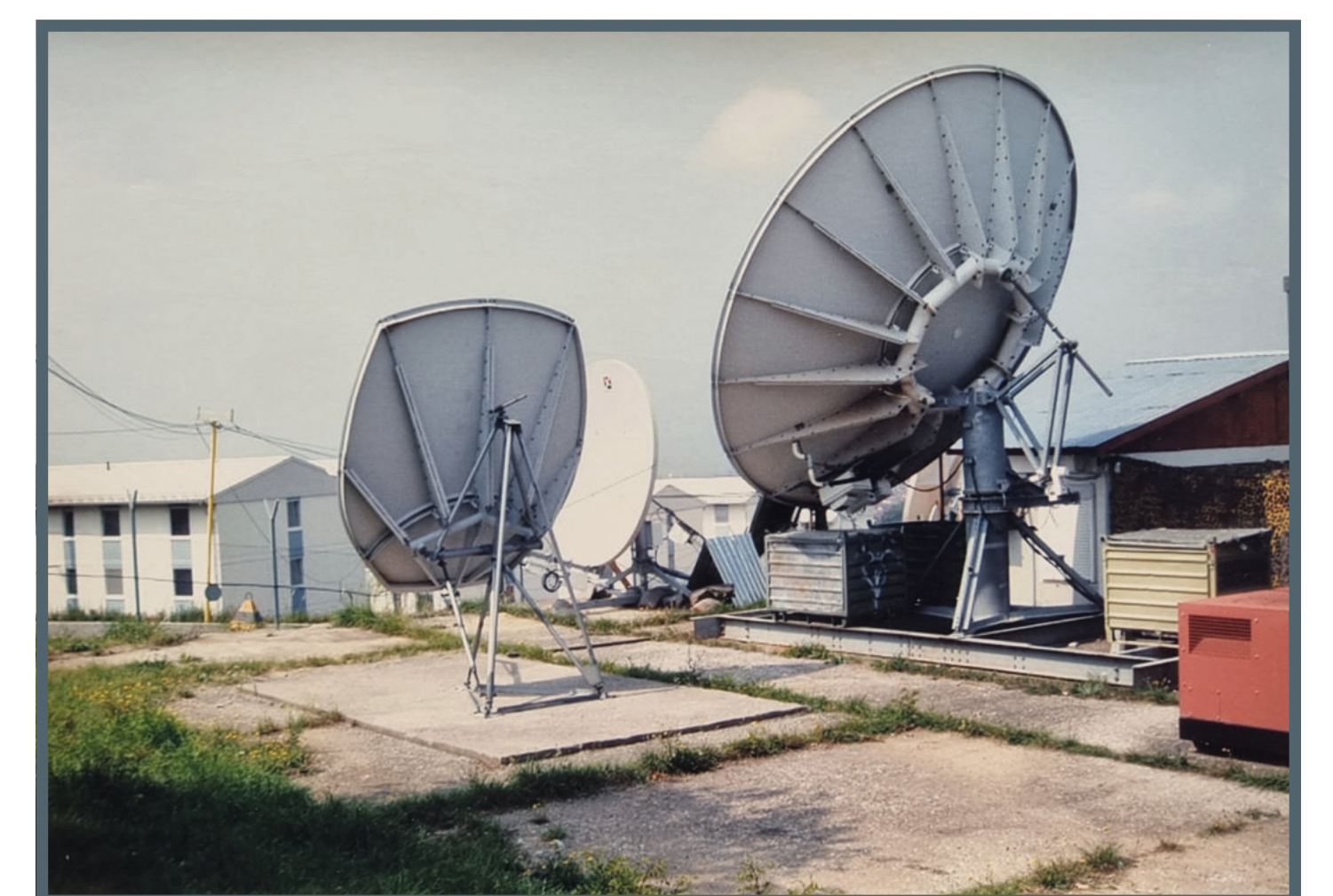
Die Antennenspiegel einer stationär betriebenen Satcom-Mehrkanal-Anlage im Einsatzgebiet
