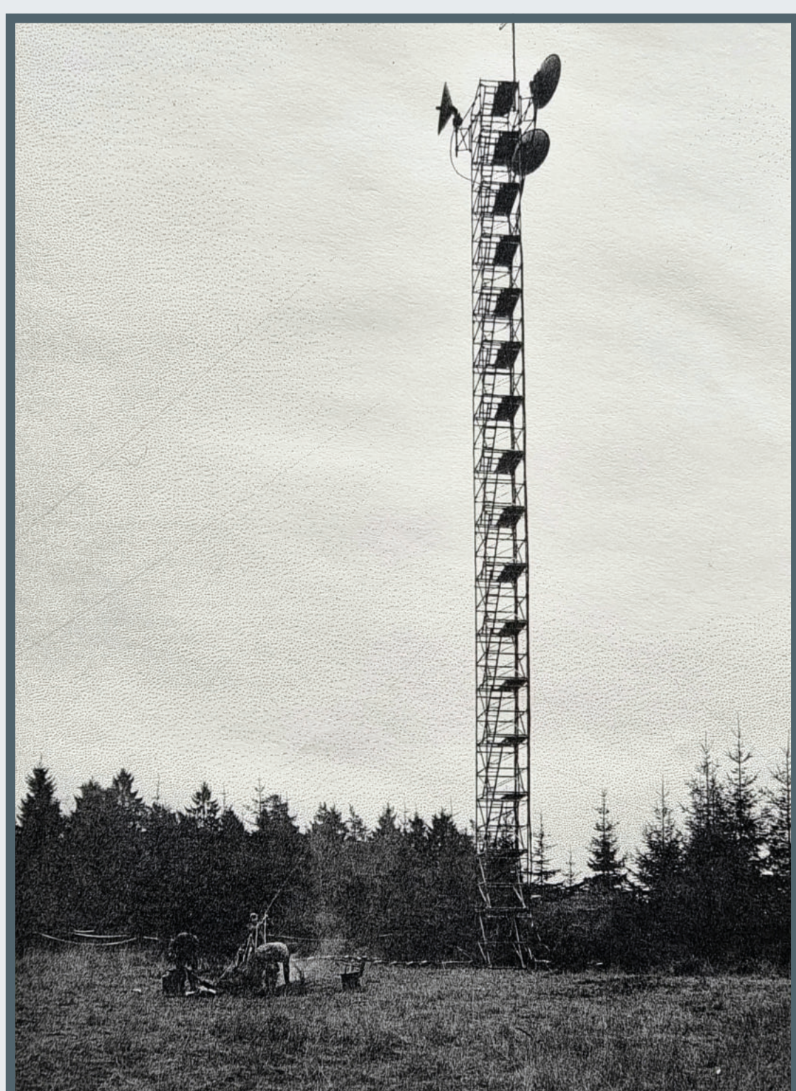
Antennenturm einer Relaisstelle der 120-Kanal-Richtfunkverbindung Mayen – Erfurt
