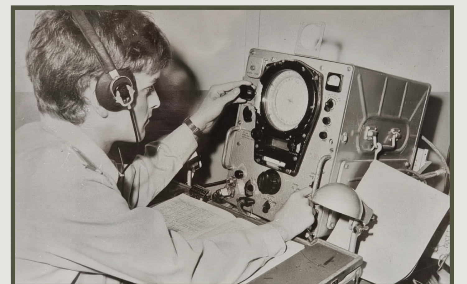
Zentraler Funkdienst (ZFD) – Funkaufklärungs-Regiment – Arbeitsplatz (Peilung) in der stationären Funkaufklärungszentrale (Peilempfänger „Pelikan“)
