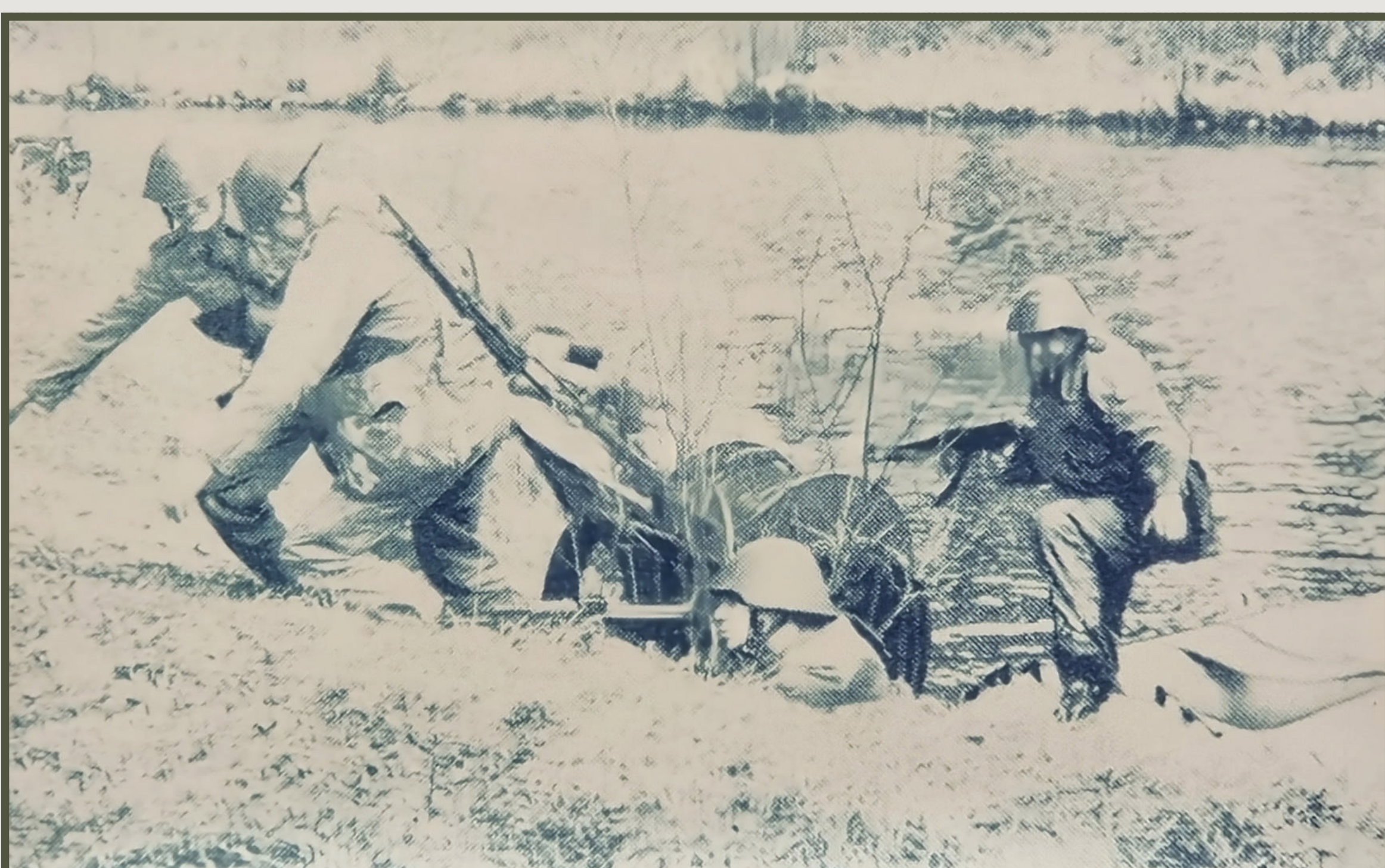
Ein Feldfern-kabel-Bautrup überquert ein Wasserhindernis
