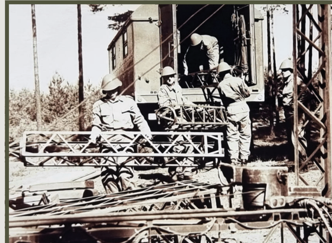
Der Aufbau des Gittermastes der Richtfunkstation RVG 902e, eine „Knochenarbeit“ für alle Funker des Trupps.
