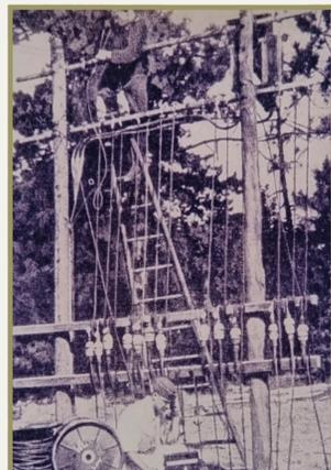
Fernsprechzentrale des AOK 10 in Schwandorf. Kabel-Abspannbock
