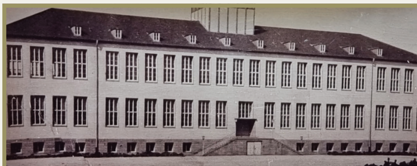
Heeres- und Luft-Nachrichtenschule Halle - Lehrsaalgebäude -
