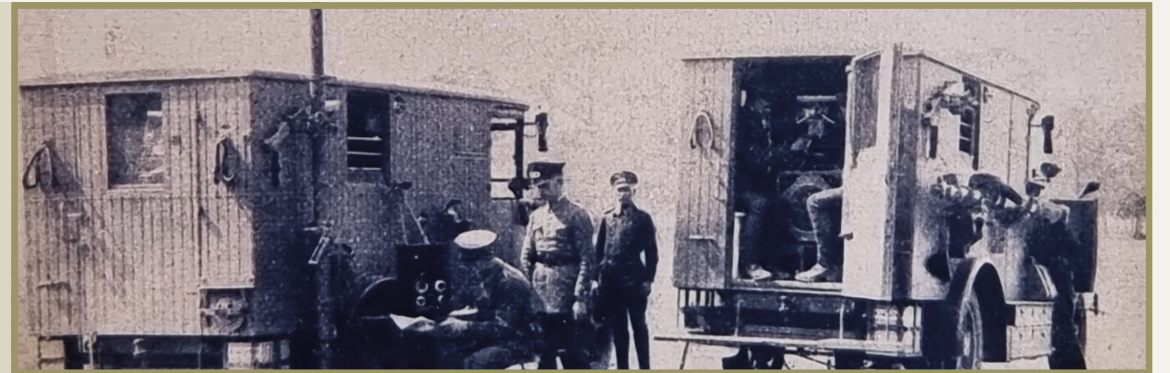
200-W-Sender Geräte- und Motorfahrzeug der „Schweren Funkstelle“ (mot.) während des Betriebsdienstes
