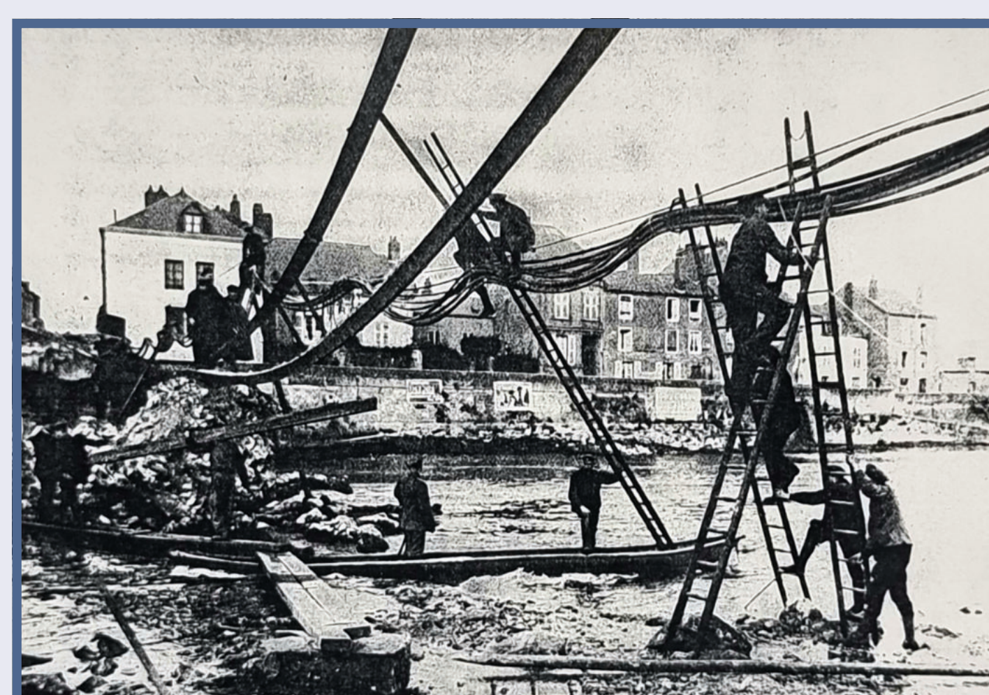
Erdkabelbau über ein Wasserhindernis auf den Ruinen einer zerstörten Brücke 1916
