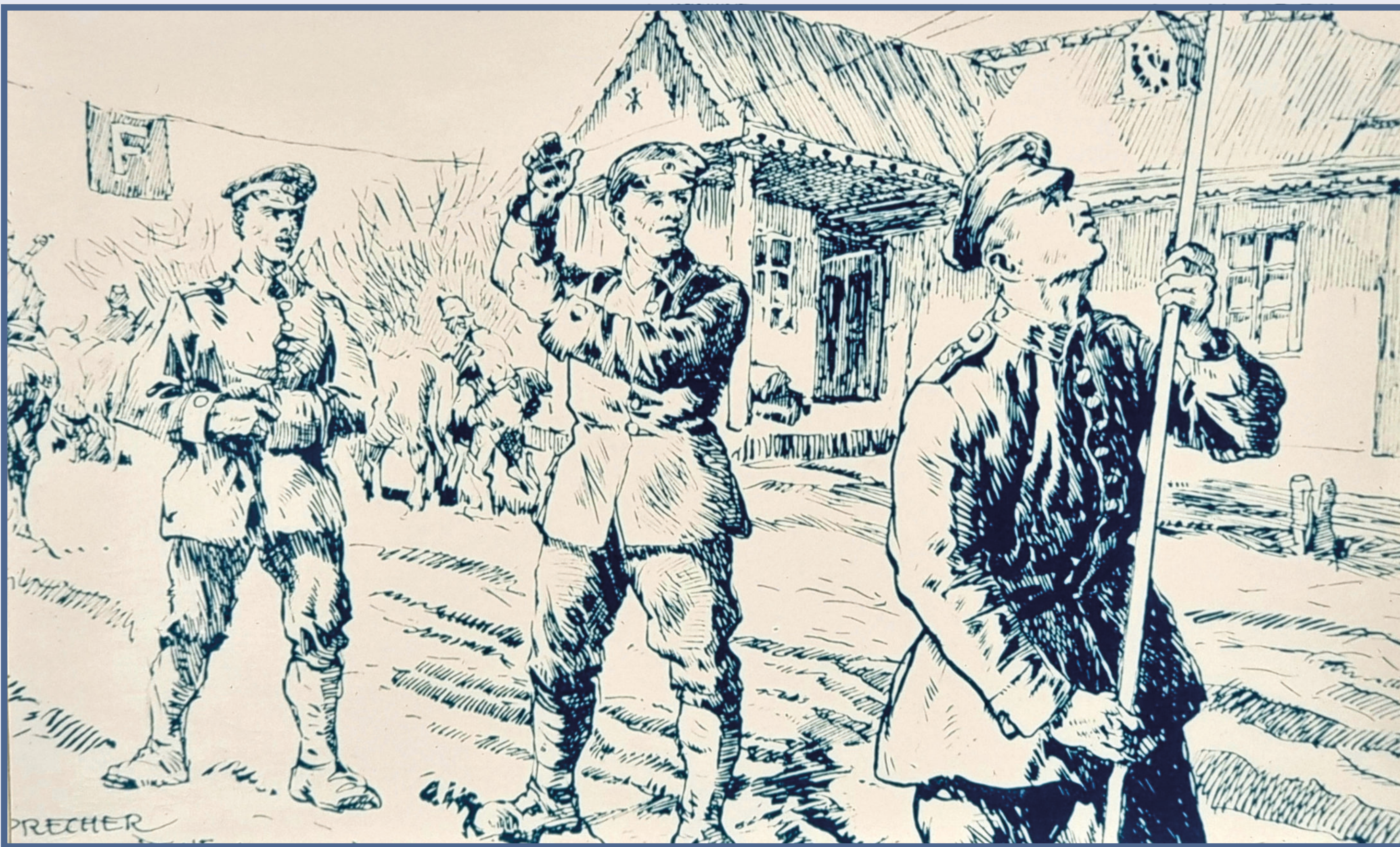
Feldkabelbau in Galizien
