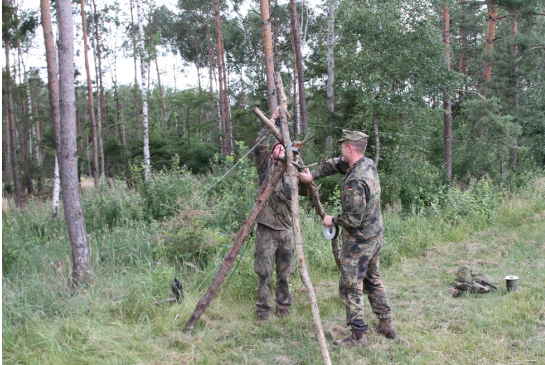
Bild 2: Aufbau eines Behelfsmastes als Antennenträger. (Foto: Bundeswehr/Engler)
